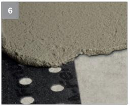
La largeur de Fentrim à crépir ne doit pas dépasser 60 mm (la zone perforée ne compte pas dans la largeur).
