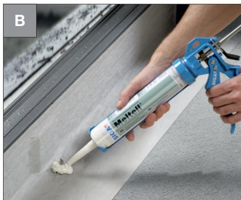
• Étancher à l'air les joints de raccordement
